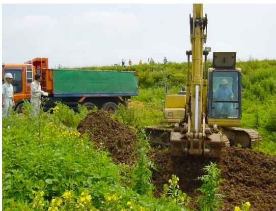
写真1 掘削及び運搬車への積込
