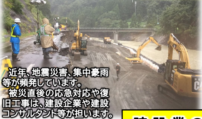
崩壊した道路の応急復旧 ～平成28年台風災害時 (岩泉町)
