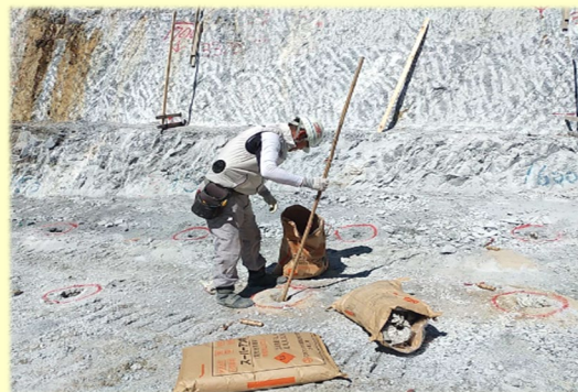
あけた穴に爆薬等を詰めている状況 (「火薬類取締法」に則って、資格保有者が作業)
