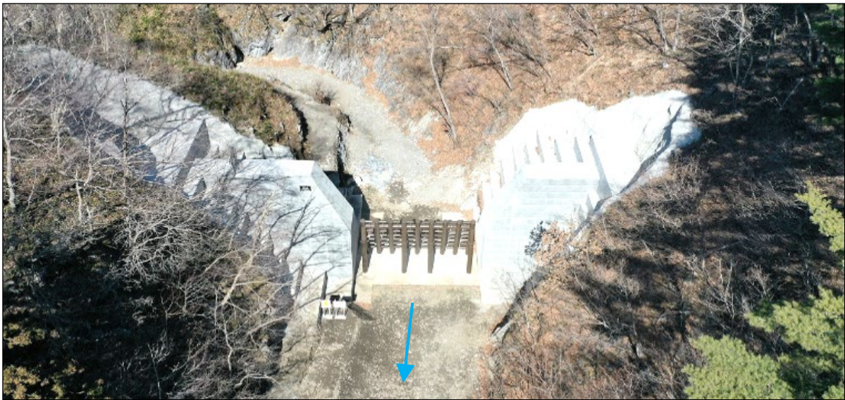
～松林の沢(新) 堰堤完成状況～
