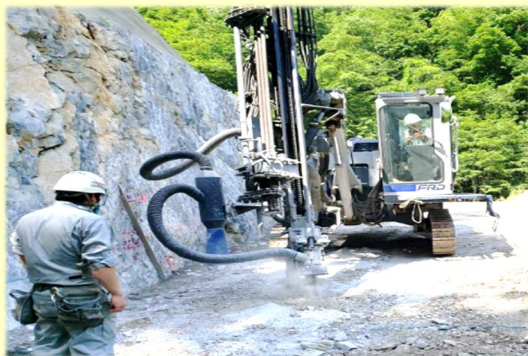
爆薬を詰める穴をあけている状況
