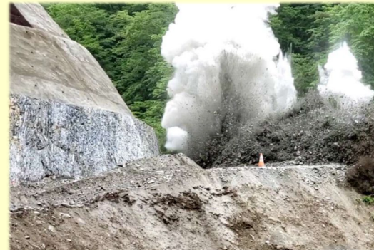
発破スイッチを押して岩盤が破碎された状況 (発破5分前、1分前、発破終了時にサイレン鳴らし周囲に合図)
