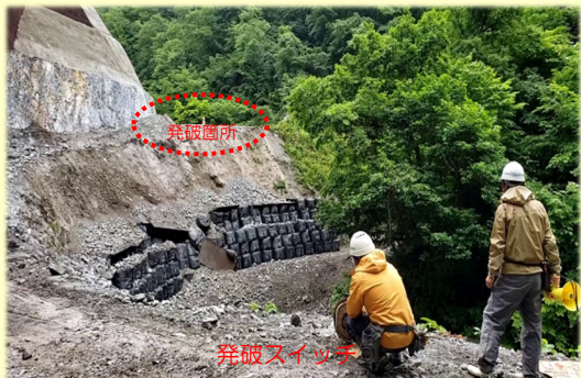
導火線 (電線) により発破スイッチと接続
