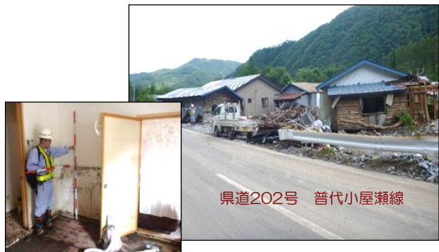
人家の被害状況
