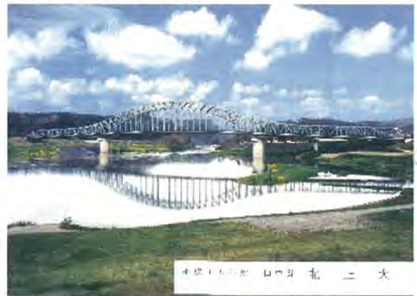
次世代にその優美な姿を引き継ぐ北上大橋の全景
