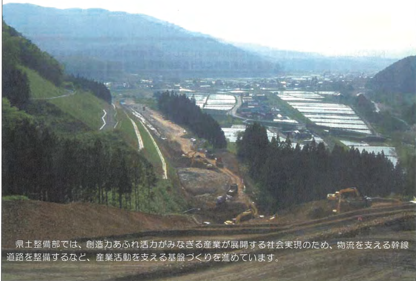
一般国道 283 号仙人道路地区(遠野市)
