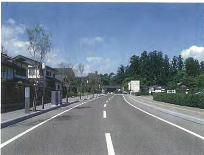
街路完成写真
