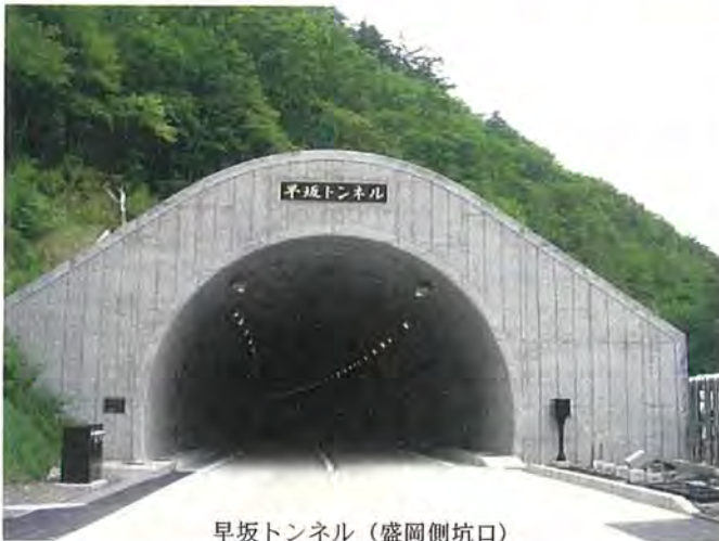
早坂トンネル（盛岡側坑口）
