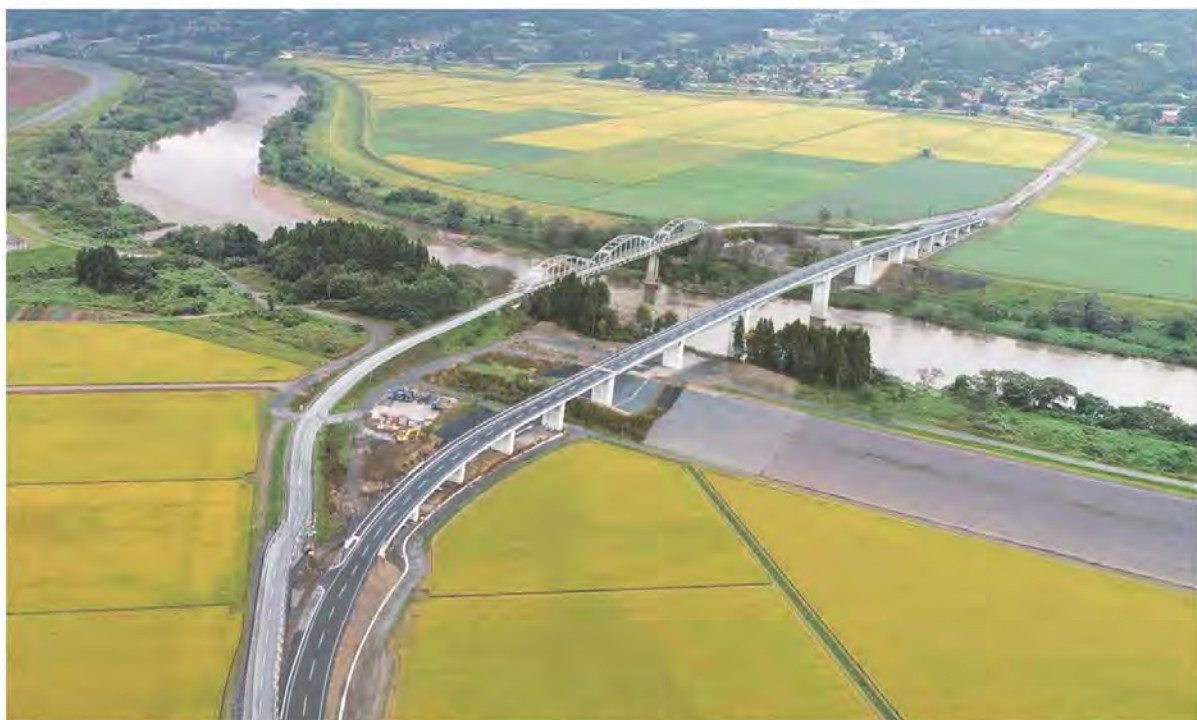
左側が旧「柵の瀬橋」、右側が新「柵の瀬橋」です。将来においても地域の人々に親しまれる橋梁となるよう、周囲の田園風景との調和などに配慮し、景観やデザインを検討しました。
