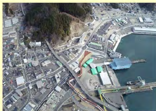
▲ 津波復興拠点整備事業「釜石市東部地区」 (令和2年3月撮影)
