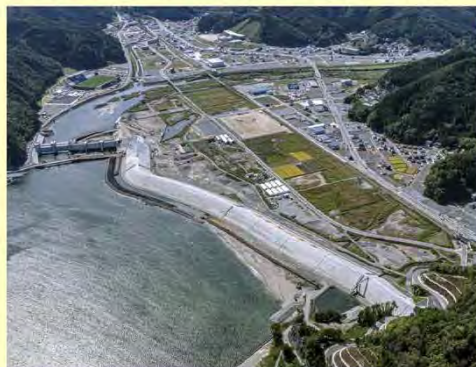
▲片岸海岸(釜石市):令和元年9月整備完了
