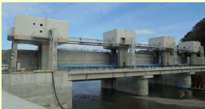
▲田代川(宮古市):令和3年3月整備完了
