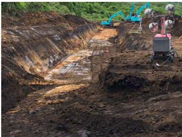
▲埋却溝の掘削：5月29日 📷①
