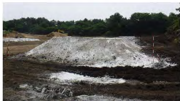
▲埋却溝の覆土：6月18日 (📷③)
