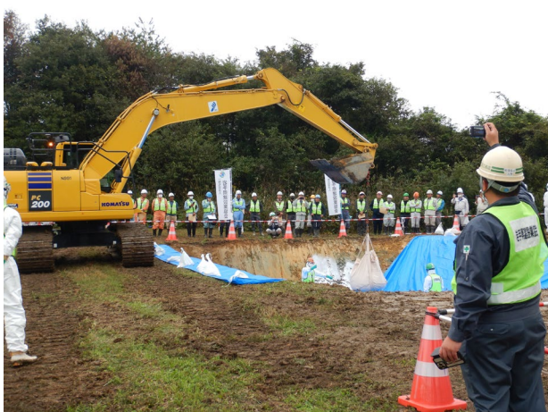
埋却訓練（フレコンバック投入）
