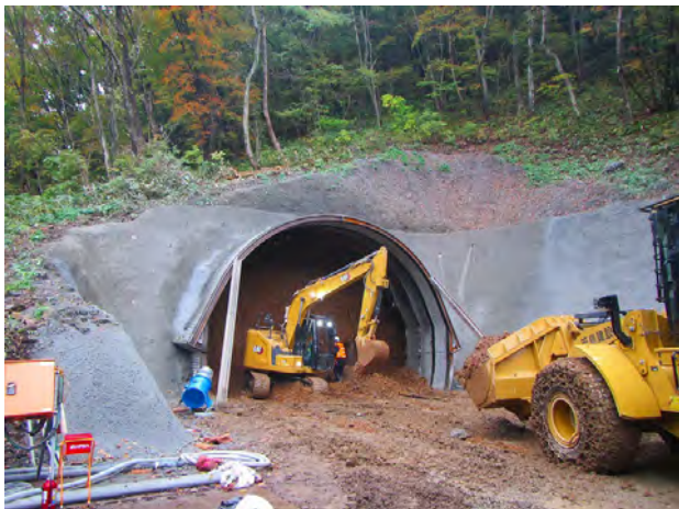
坑口部の掘削状況 (10月24日)
