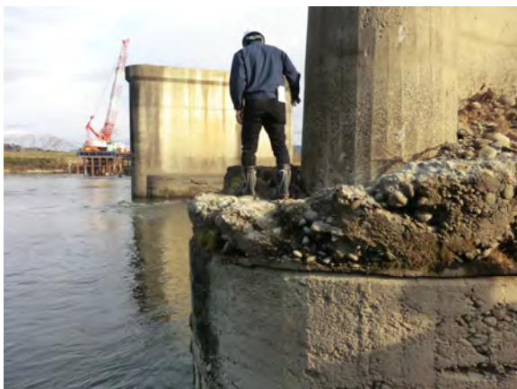
国総研、土研による現地調査
