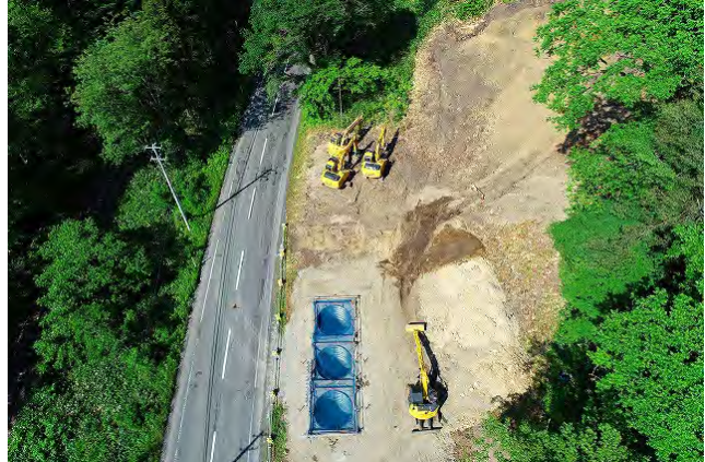
ヤード造成状況（令和6年6月14日）
