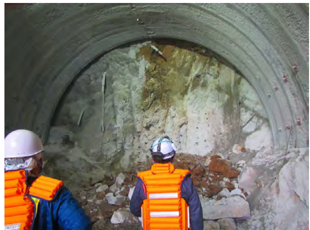
切羽状況：坑口から21m地点 (11月12日)
