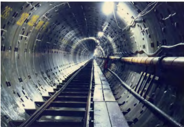
中央幹線のシールド工事（昭和53年頃）
