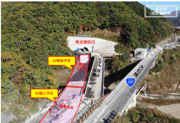
【終点側坑口（西和賀町側）現在の状況と施工予定】
