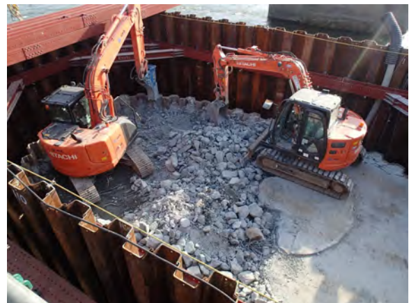
仮締切内での橋脚基礎取壊し
