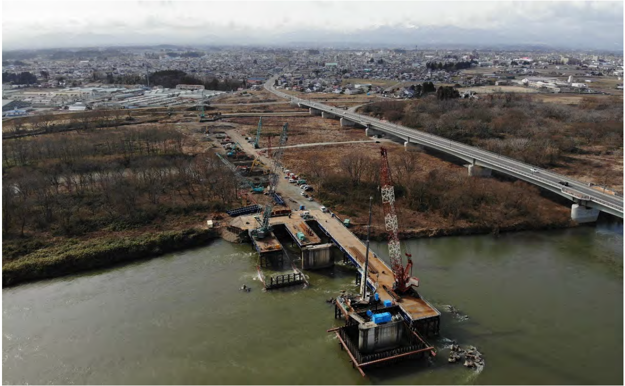
【河川流水部で行った橋脚撤去工事】
