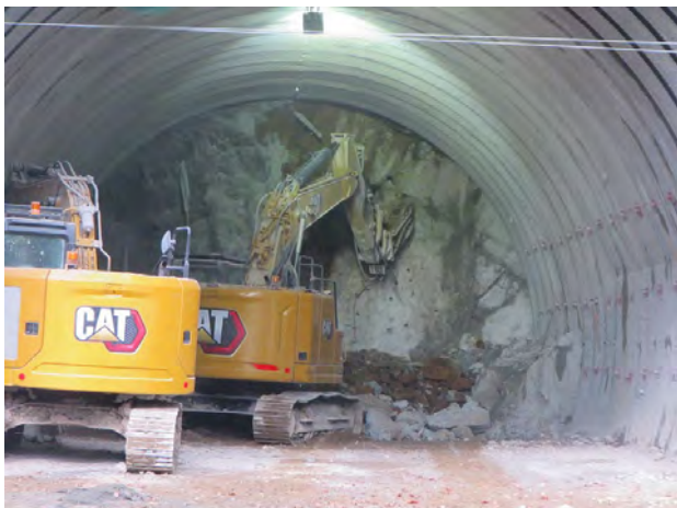
掘削状況：坑口から20m地点 (11月12日)
