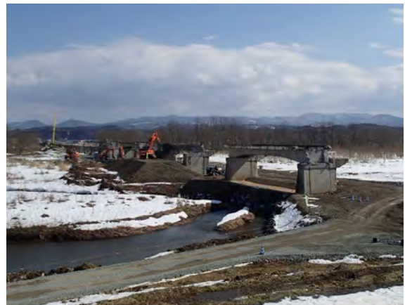
大型ブレーカーによるRCゲルバー桁の取壊し
