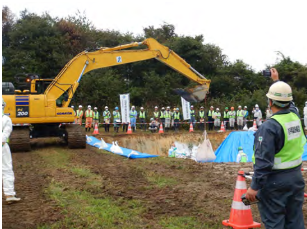
埋却訓練（フレコンバック投入）
