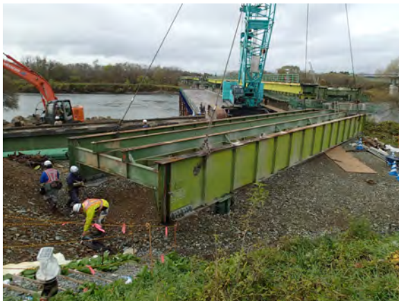
クレーンによる鋼鈹桁の吊り上げ撤去
