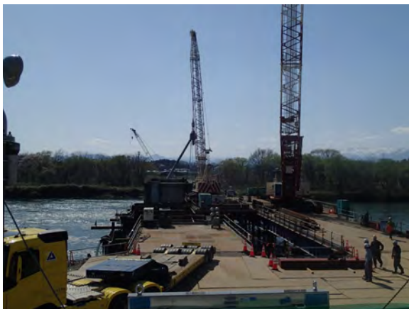
河川流水部での仮設工の設置状況
