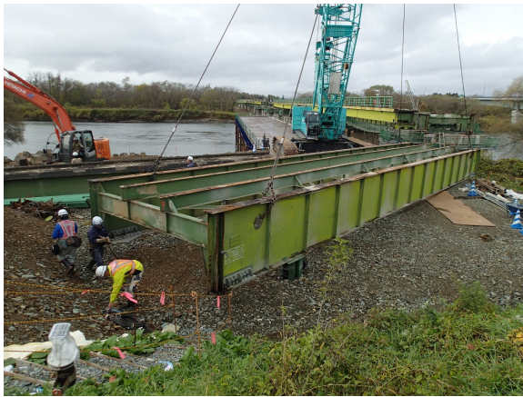
クレーンによる鋼鉄桁の吊り上げ撤去
