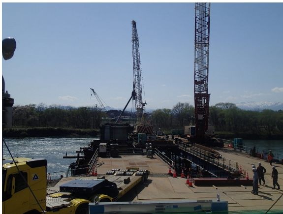
河川流水部での仮設工の設置状況
