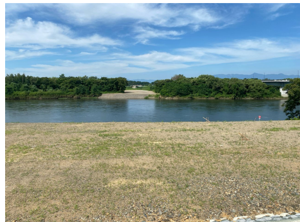
橋脚撤去後の状況 (A1橋台からA2橋台を望む)
