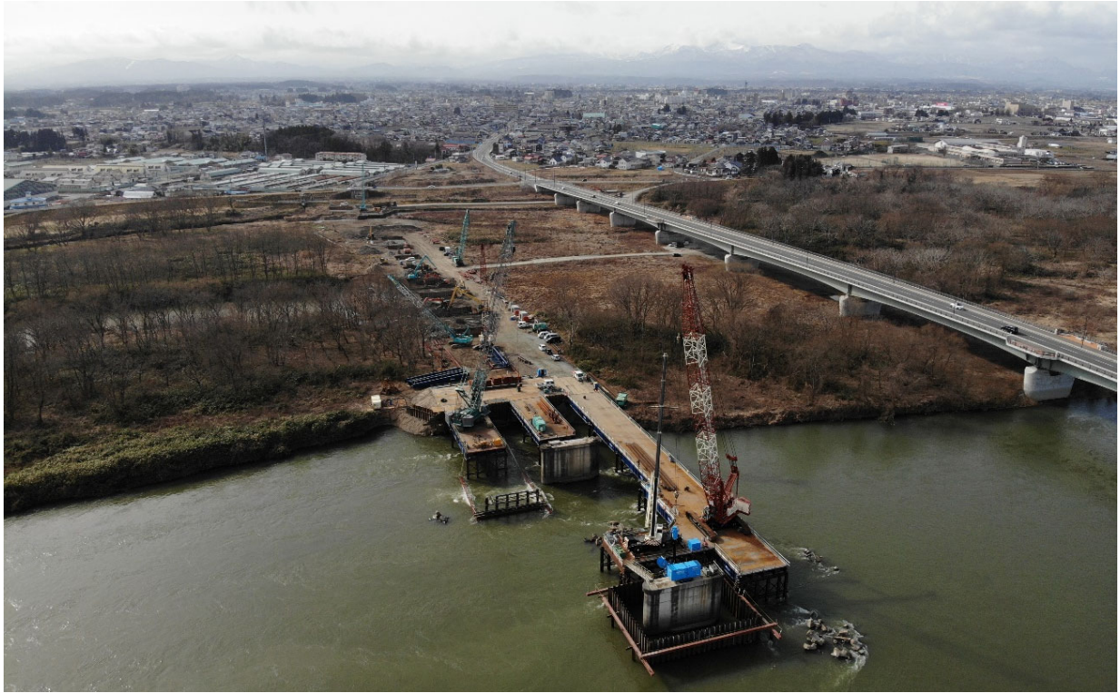
【河川流水部で行った橋脚撤去工事】
