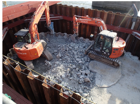
仮締切内での橋脚基礎取壊し
