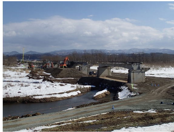
大型ブレーカーによるRCゲルバー桁の取壊し
