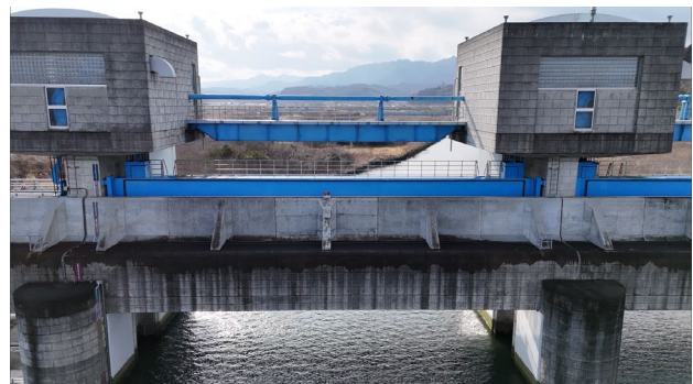
みお筋上空カーテンウォール、支柱
