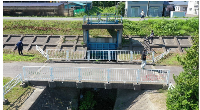
築堤及び樋門を撮影
