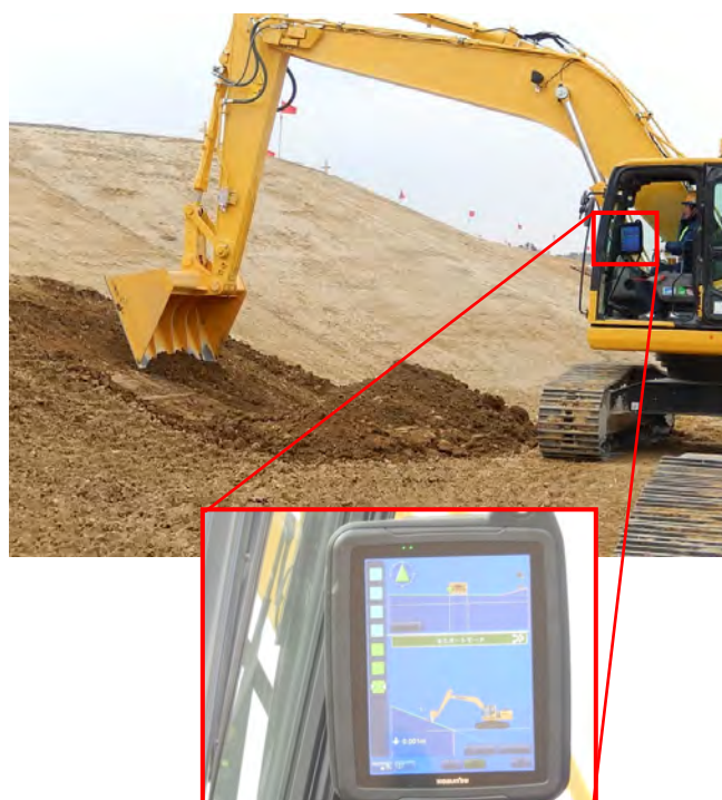
ICT建設機械による施工状況
