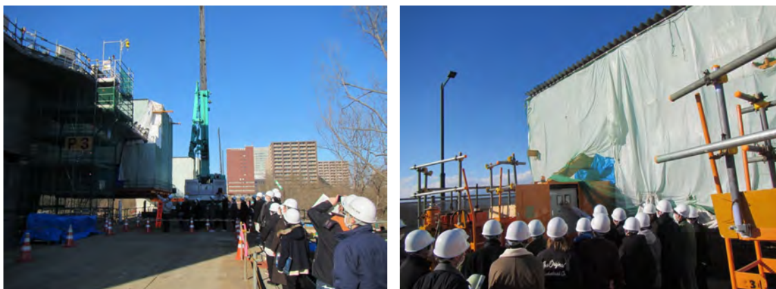
現場見学会の状況（都市計画道路 盛岡駅本宮線 杜の大橋）
