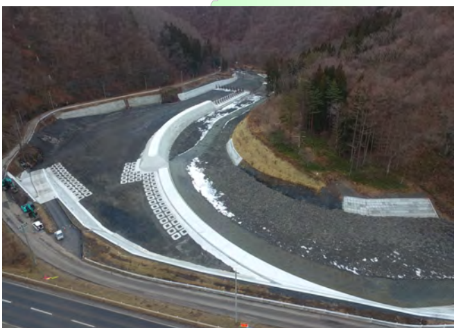
小本川流木捕捉工完成 (令和5年1月 岩泉町)
