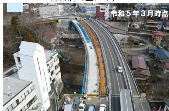
整備中 都市計画道路荒瀬上田面線 岩谷橋（二戸市）
