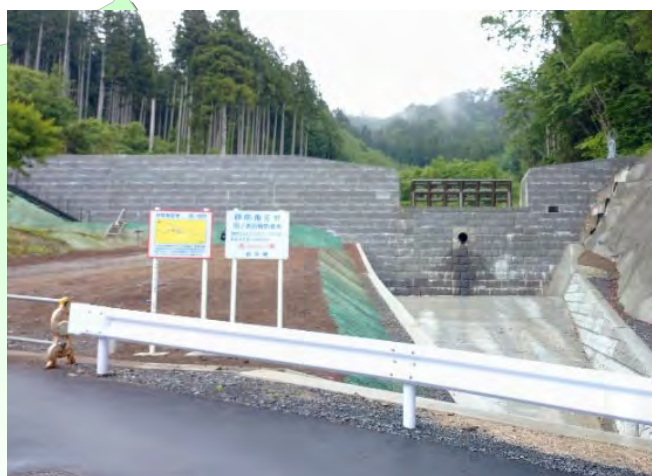
田ノ浜沢砂防堰堤完成 (令和5年5月 山田町)
