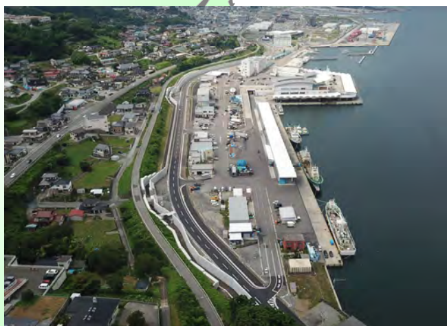
一般県道丸森権現堂線下船渡工区全線供用 (令和4年7月 大船渡市)
