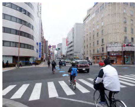
主要地方道盛岡停車場線の整備状況 (令和4年度実施：矢羽根の整備)
