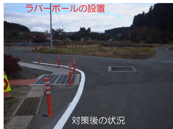
対策イメージ（車道分離標(ラバーポール)の整備） 主要地方道大船渡広田陸前高田線 天王前工区（陸前高田市）
