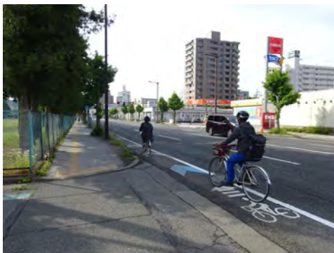
主要地方道盛岡横手線の整備状況 (令和4年度実施：矢羽根の整備)
