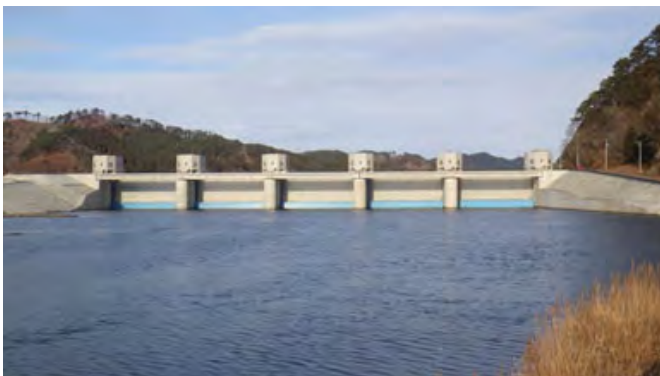
鵜住居川水門の閉鎖状況（釜石市）
