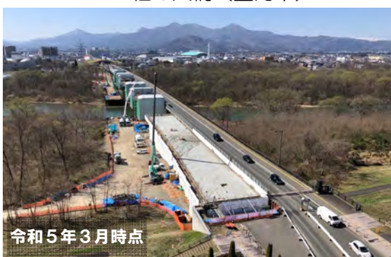
整備中 都市計画道路盛岡駅本宮線 杜の大橋（盛岡市）
