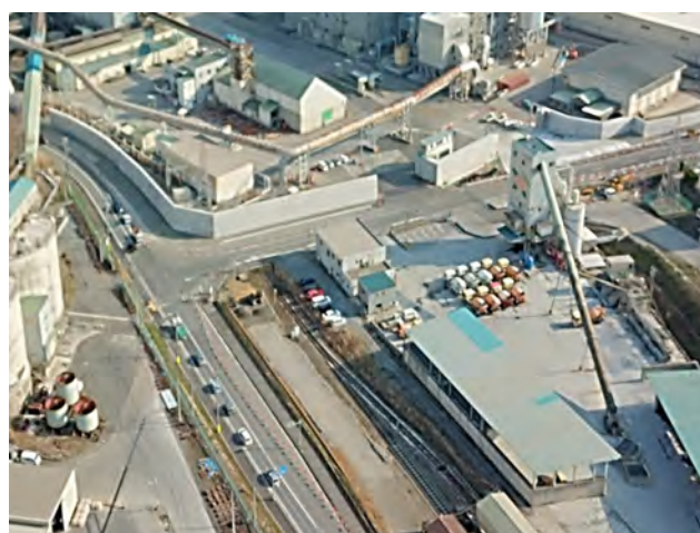
令和5年度完成予定 普金地区海岸（大船渡市）
