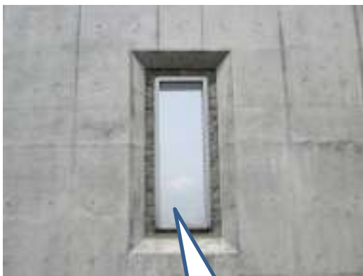
スリット窓を設置
