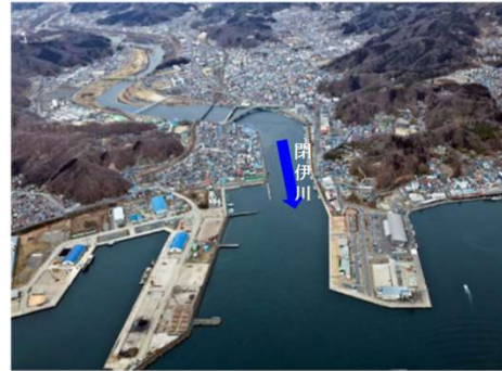
被災前状況 H23.3.9 撮影
