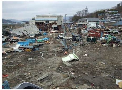
閉伊川左岸河口部被災状況
