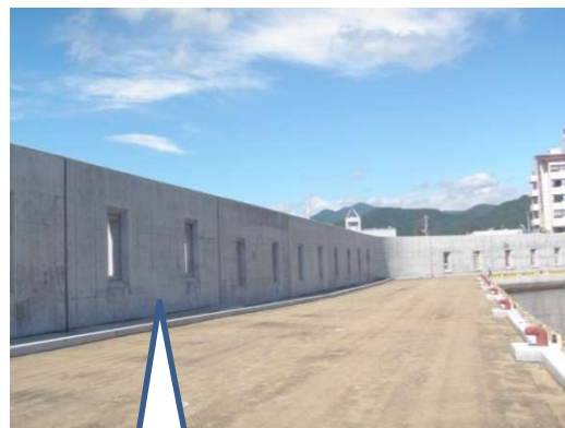
スリット窓を設置
