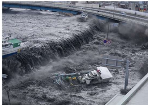
閉伊川堤防越流状況(宮古大橋直下流)
