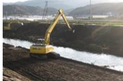
河道掘削の状況
