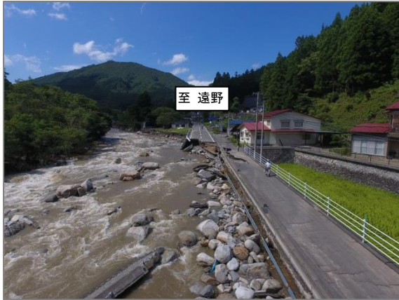
(被災時: 河川出水により道路が流出)
