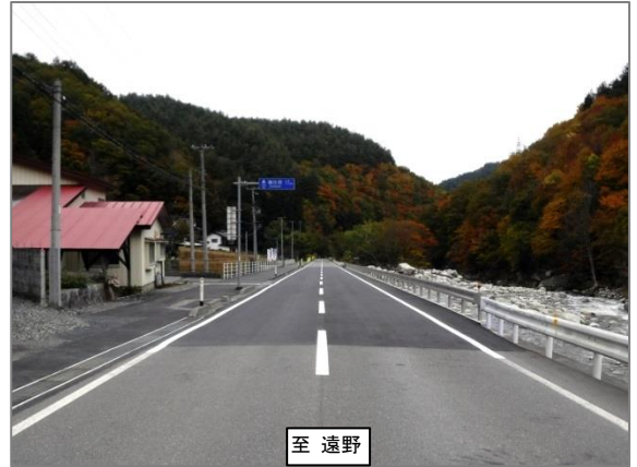
(復旧後: 流出した道路の復旧及び護岸復旧)
