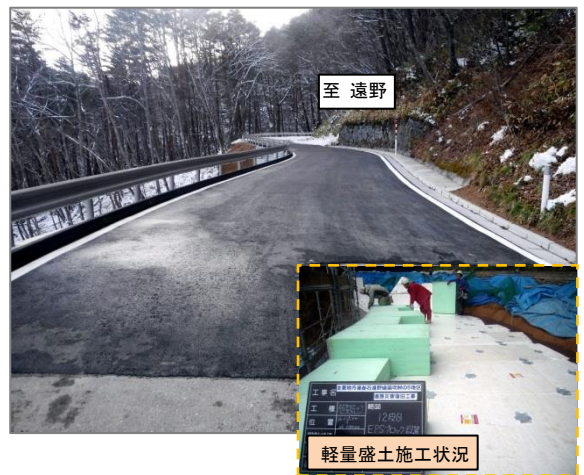
(復旧後: 軽量盛土工法により道路復旧)
