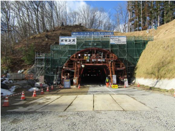
（仮称）田鎖トンネル 工事起点側
