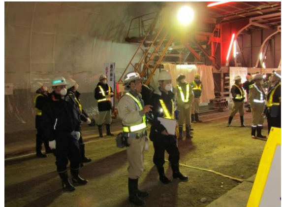
パトロール時の点検状況
