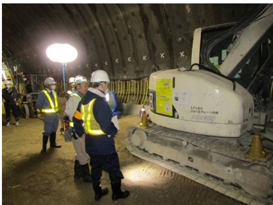
パトロール時の点検状況
