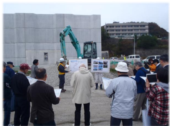
防潮堤工事の現場
