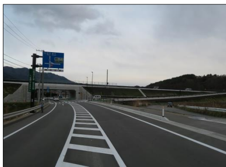
豊間根工区 (山田北 IC 付近)
