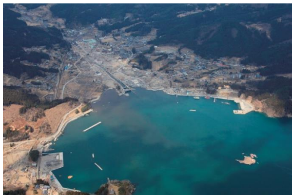
被災後（平成 23 年 3 月 29 日）
