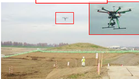
①UAVによる測量状況
