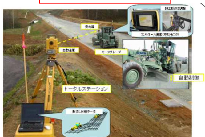
④マシンコントロールによる施工状況
