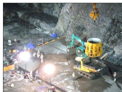
夜間打設状況
