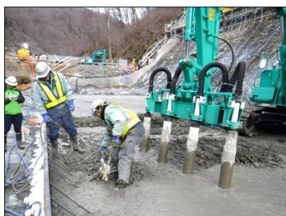
内部振動機による締固め
