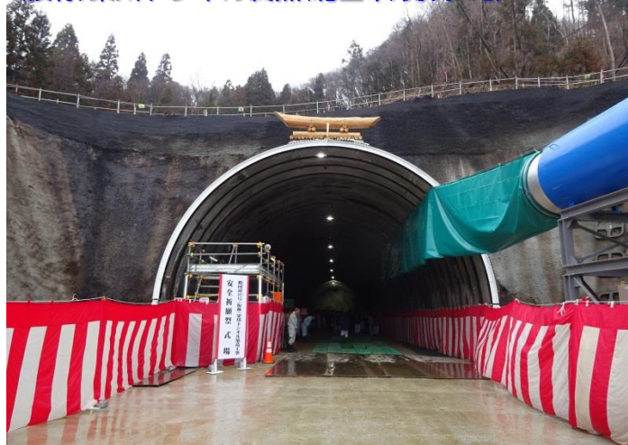
(仮称)梁川トンネル終点(北上市)側坑口部
