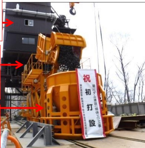
製造したコンクリートをバケットに積み込み
