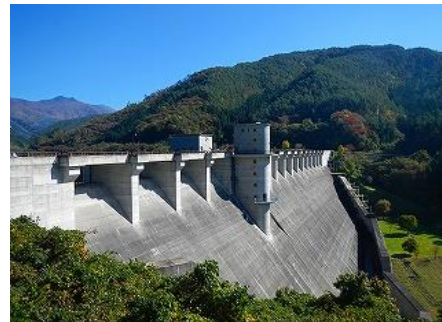
早池峰ダム全景
