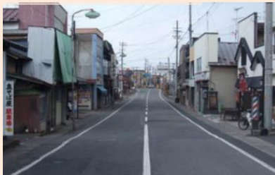
着手前状況（平泉駅前）
