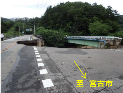
④古田地区道路陥没及び土砂流出
