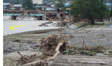
⑦ 褒綿地区の被災状況
