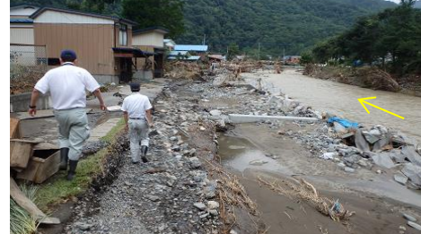
⑥ 褒綿地区の被災状況
