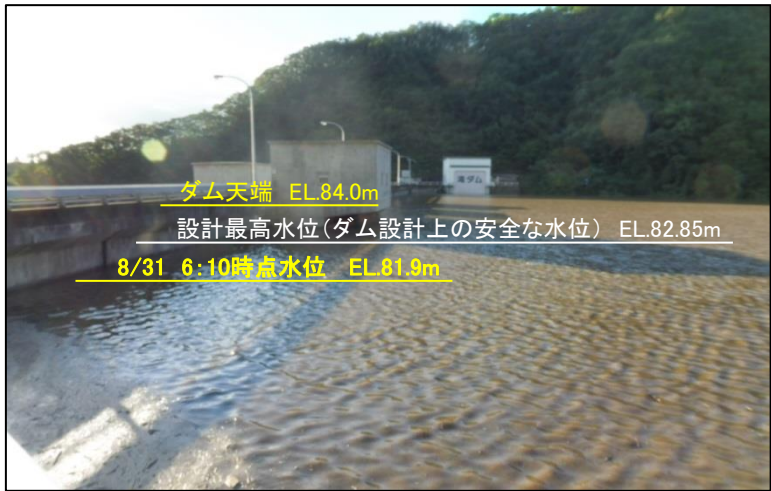
滝ダム 貯水状況 (8/31 6:10)
