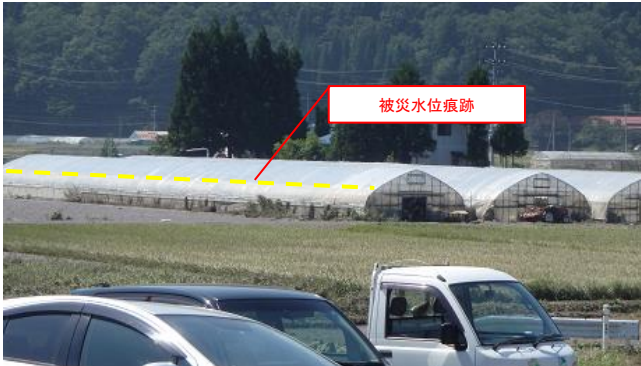
② 浸水被害状況
