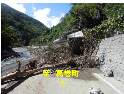
⑦ロッキーパー付近の被災状況
