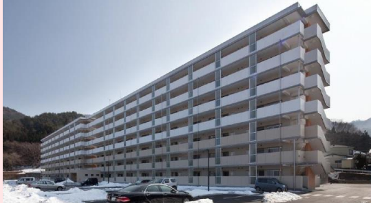
釜石市 平田地区災害公営住宅 (H26.1完成)
