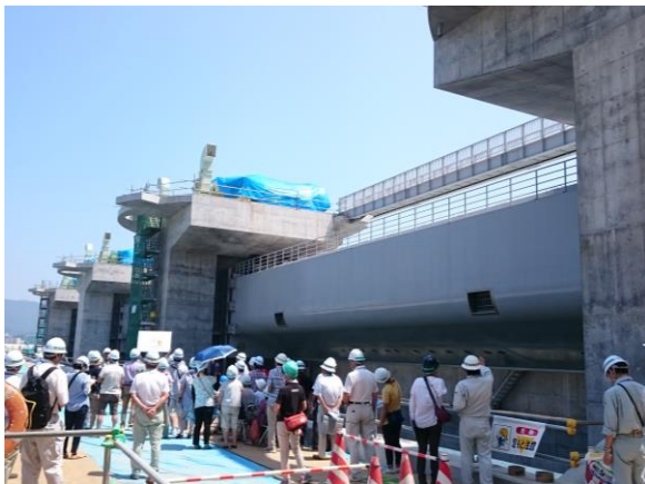
管理橋の上から水門の仕組みを確認
