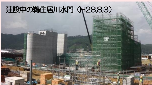
建設中の片岸海岸防潮堤（H28.8.3）
