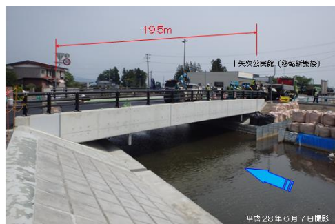
完成した岩崎川橋(新橋)
