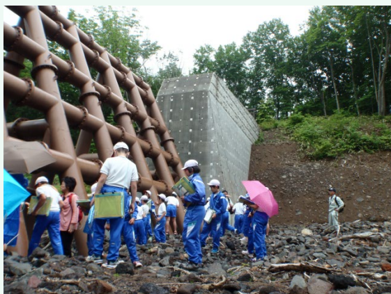
砂防堰堤の大きさに圧倒されます
