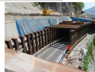
仮設プロテクター撤去状況
