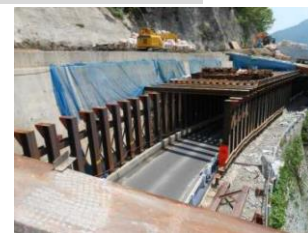
仮設プロテクター撤去状況
