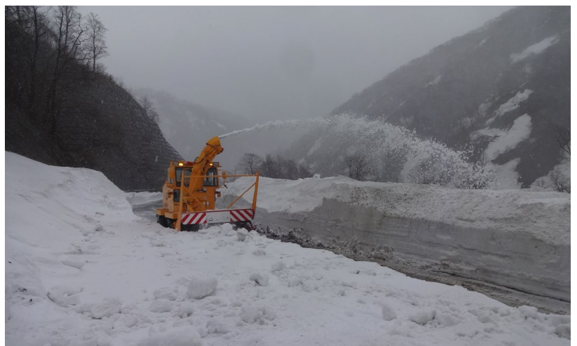
一般国道 397 号の除雪状況
