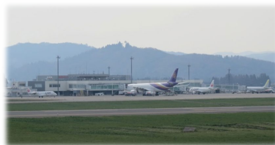
増築により初めて実現した国際チャーター便と国内定期便3便が同時駐機する様子
