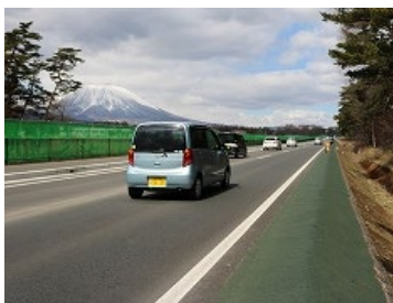
上下線分離区間 下り線（開通後）
