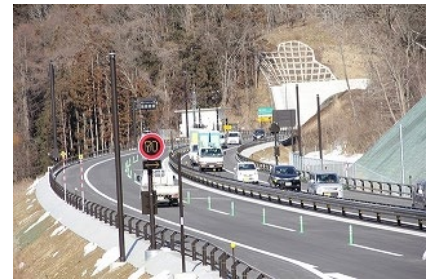
開通後の状況 (田の沢 IC 付近)
