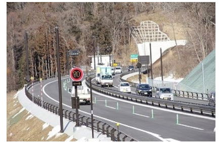
開通後の状況 (田の沢IC付近)
