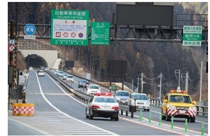
開通後の状況 (川目IC付近)
