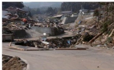
川代地区：道路浸水
