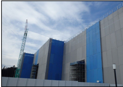
(左) メッシュシートで覆われ外部足場の昇降階段位置が分からないので、シートの色を変えています。 (中・右) 転落防止のため、注意書きを明示して開口部の養生をしています。
