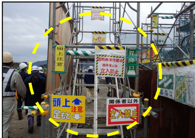
(左・中) 可動式の注意看板を設置し、関係者以外の立入禁止と立入者への注意喚起を同時に行っています。 (右) 頭上危険箇所の保護をするとともに、注意喚起のためにテープを下げています。
