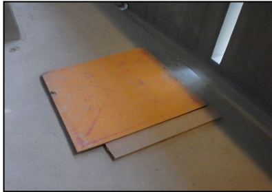
(左) メッシュシートで覆われ外部足場の昇降階段位置が分からないので、シートの色を変えています。 (中・右) 転落防止のため、注意書きを明示して開口部の養生をしています。
