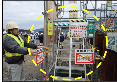
(左・中) 可動式の注意看板を設置し、関係者以外の立入禁止と立入者への注意喚起を同時に行っています。 (右) 頭上危険箇所の保護をするとともに、注意喚起のためにテープを下げています。
