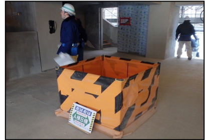
(左) メッシュシートで覆われ外部足場の昇降階段位置が分からないので、シートの色を変えています。 (中・右) 転落防止のため、注意書きを明示して開口部の養生をしています。
