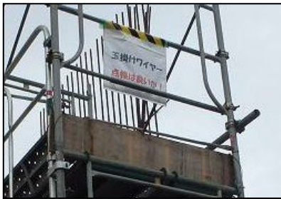
(左) 作業場所に玉掛作業に関する標識を設置し、注意喚起しています。足場端部にも幅木が設置されています。 (中) 段差注意の明示をするとともに、階段部では階段を色分けして着色し、さらに注意喚起しています。 (右) 昇降口が分かりやすいよう、明示しています。
