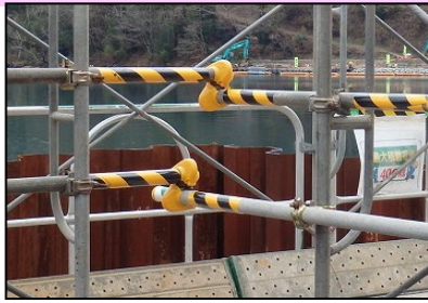
(左) 足場板は、すれやすく、隙間ができるので、鉄線で連結しています。 (中) 激突防止のため、コーナー部の手すり突起部にキャップをしています。 (右) 型枠脱型用の金物器具にコードを取り付け、腰に連結しています。セパレーターから不意にはずれても落下しないようにしています。
