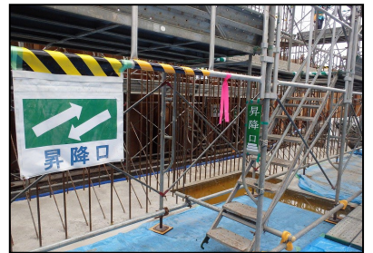
(左) 作業場所に玉掛作業に関する標識を設置し、注意喚起しています。足場端部にも幅木が設置されています。 (中) 段差注意の明示をするとともに、階段部では階段を色分けして着色し、さらに注意喚起しています。 (右) 昇降口が分かりやすいよう、明示しています。
