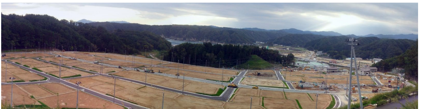
田老地区防災集団移転促進事業の状況（9/28 撮影）
