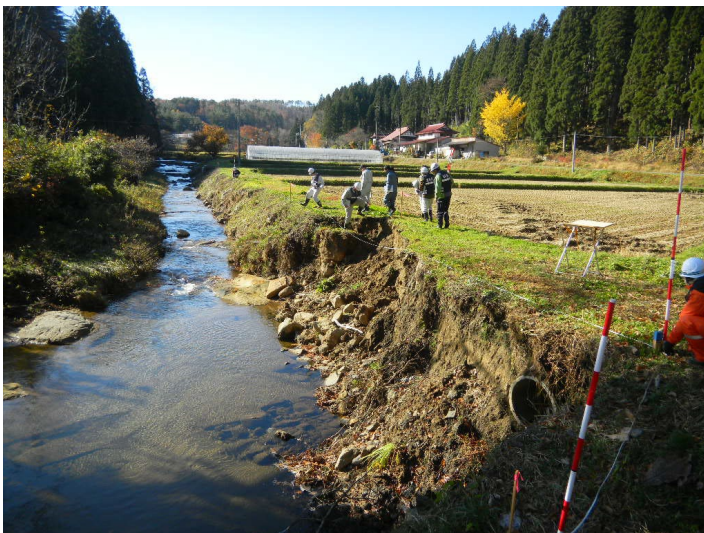
一関土木センター管内
