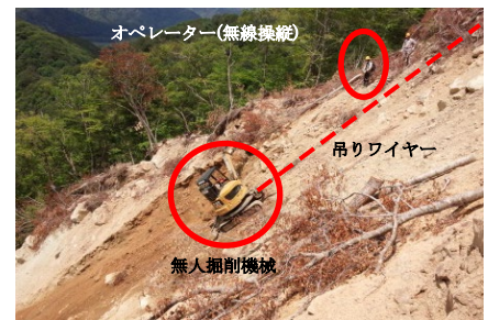
土砂撤去状況
