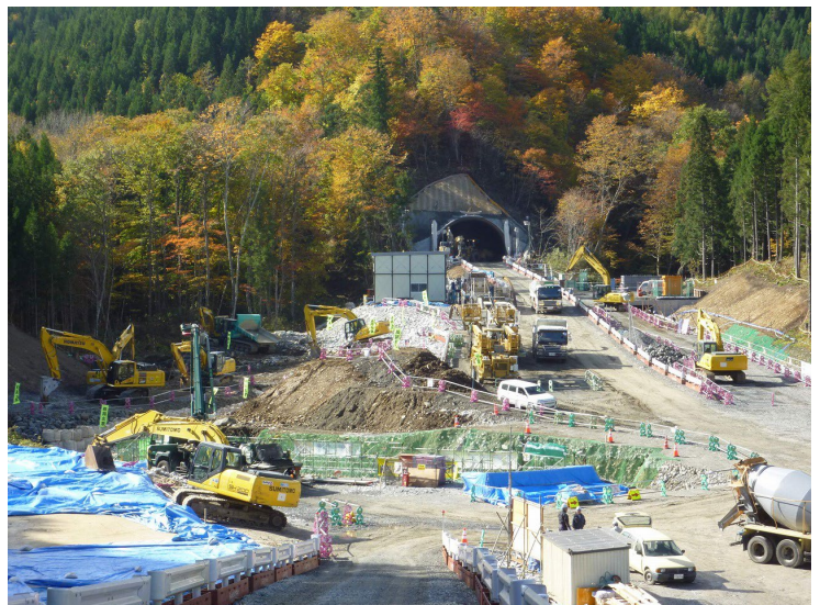
宮古側からトンネル坑口を望む [H27. 10. 15 撮影]
