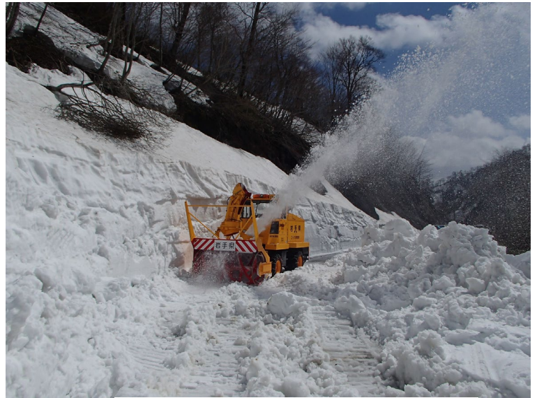
一般国道 397 号の除雪状況
