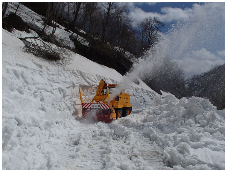
一般国道 397 号の除雪状況
