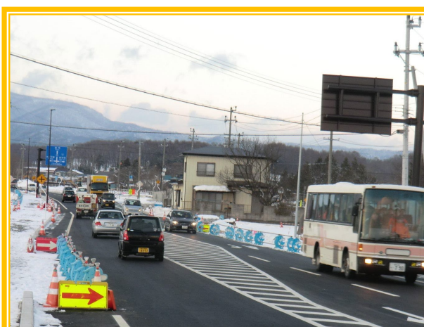
開通後には、開通を待ちわびた多くの車両が通行を開始し、多くの利用者が喜んでいました。
