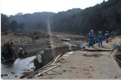
里地区 (落橋した向流橋)
