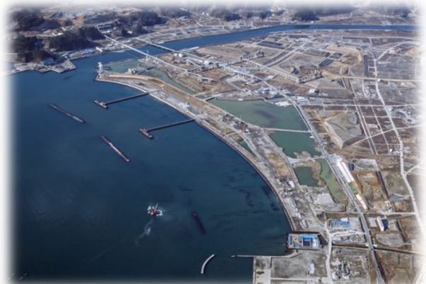
現在の復旧状況：平成 26 年 12 月 8 日撮影
