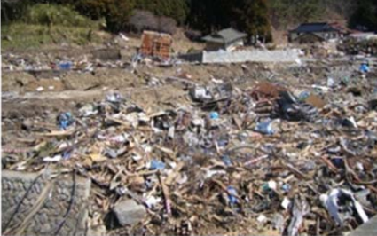
石浜地区 (崩落した県道)
